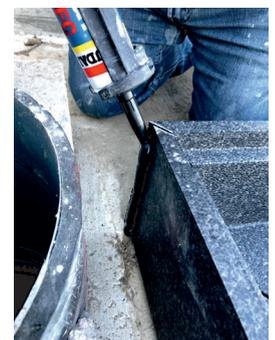
5. Gehrungen und Schrauben mit Montagekleber verschließen
